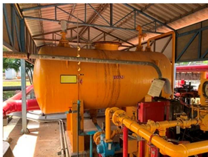
รูปที่ ข-27 ระบบโคมอยู่บริเวณตรงข้ามกับอาคารทำการนายท่า โดยจะมีท่อโคมส่งไปที่ถังเก็บน้ำมันทุกถัง
