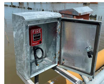
รูปที่ ข-14 กล้องสัญญาณแจ้งเตือนกรณีเกิดเพลิงไหม้บริเวณท่าเทียบเรือ และภายในอาคารควบคุมที่ศูนย์ฝึกอบรมบางปะกง
