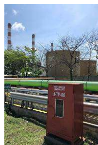
รูปที่ ข-32 หัวจ่ายน้ำดับเพลิง Hydrant ติดตั้งบริเวณรอบนอกของถังเก็บน้ำมัน
