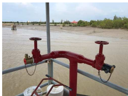
รูปที่ ข-22 หัวจ่ายน้ำดับเพลิงและสายยางขนาด 2.5 นิ้ว อยู่ภายในตู้ Hydrant บริเวณปลายท่า
