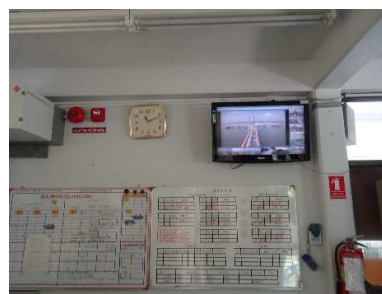
รูปที่ ข-14 กล้องสัญญาณแจ้งเตือนกรณีเกิดเพลิงไหม้บริเวณท่าเทียบเรือ และภายในอาคารควบคุมที่ศูนย์ฝึกอบรมบางปะกง
