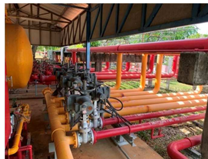
รูปที่ ข-27 ระบบโคมอยู่บริเวณตรงข้ามกับอาคารทำการนายท่า โดยจะมีท่อโคมส่งไปที่ถังเก็บน้ำมันทุกถัง
