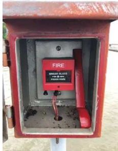
รูปที่ ข-14 กล้องสัญญาณแจ้งเตือนกรณีเกิดเพลิงไหม้บริเวณท่าเทียบเรือ และภายในอาคารควบคุมที่ศูนย์ฝึกอบรมบางปะกง
