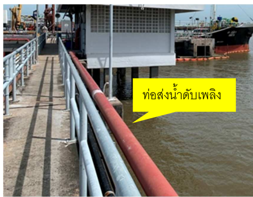
รูปที่ ข-21 ท่อน้ำดับเพลิงขนาดเส้นผ่าศูนย์กลาง 200 มิลลิเมตร
