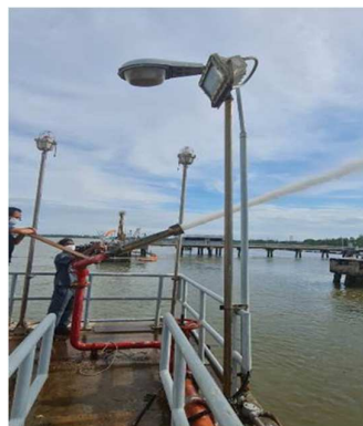
รูปที่ ข-20 เครื่องฉีดน้ำแบบตั้งอยู่กับที่
