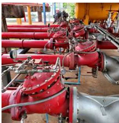
รูปที่ ข-28 ระบบ Water Spray ติดตั้งที่ถังเก็บน้ำมันทุกถัง
